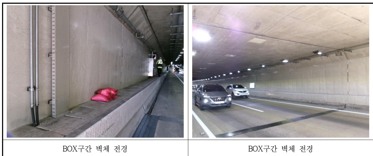
【사진 3.3.19】 BOX구간 벽체 전경
