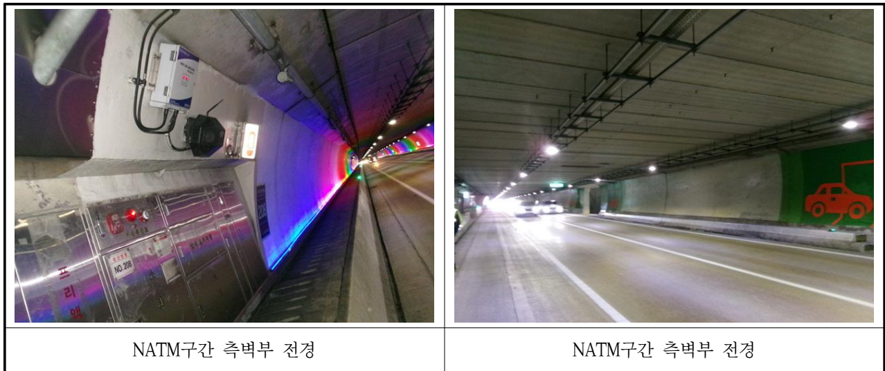
【사진 3.3.7】 NATM구간 측벽부 전경
