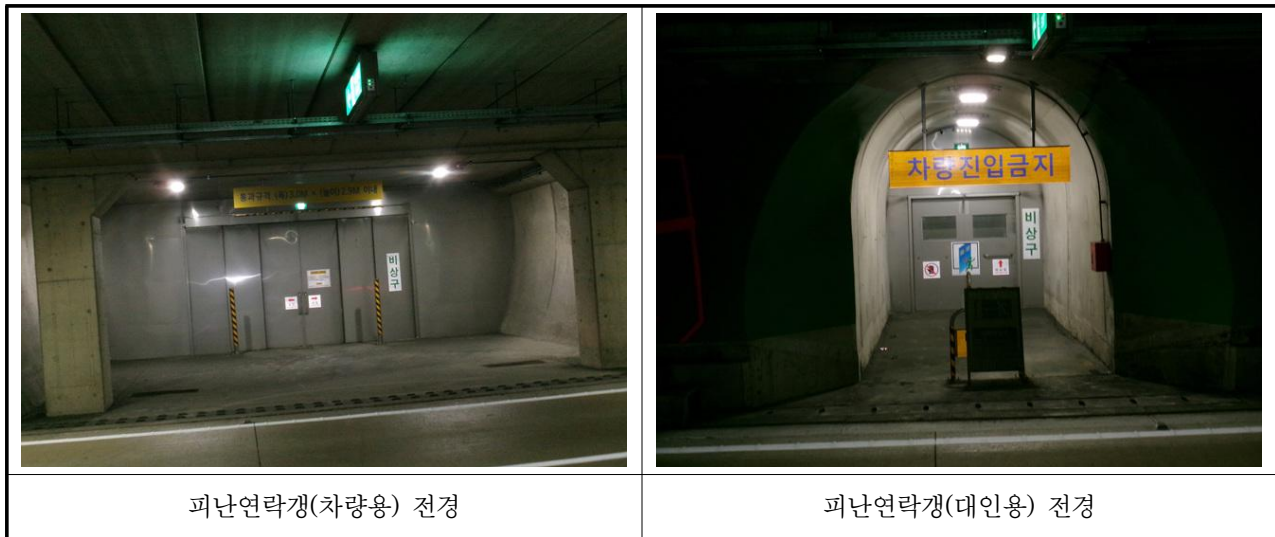
【사진 3.3.35】 피난연락갱 전경
